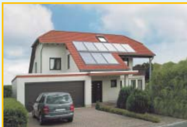
Solaranlage für Warmwasser mit Heizungsunterstützung (Bild Weishaupt)
