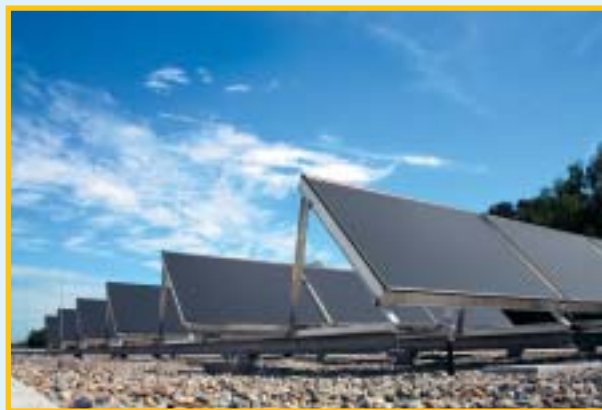
Solaranlage Flachdach (Bild Weishaupt)
