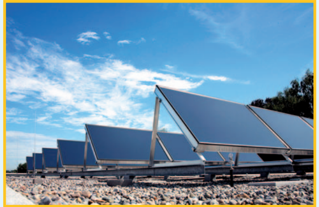
Solaranlage Flachdach
